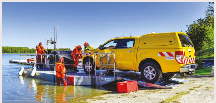
Mise à l'eau d'une barge à Saint Nicolas de la Grave
